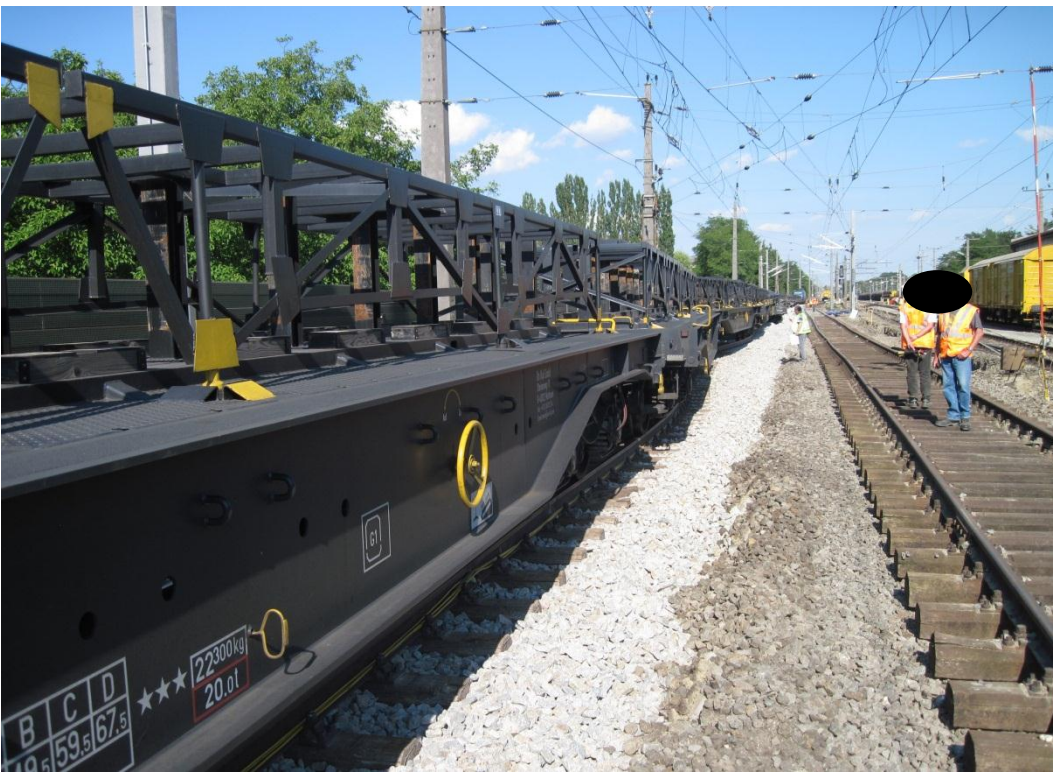
Abbildung 14 Gleisverdrückung im Bereich der Holzschwellen Weiche 203 (Quelle IM)
