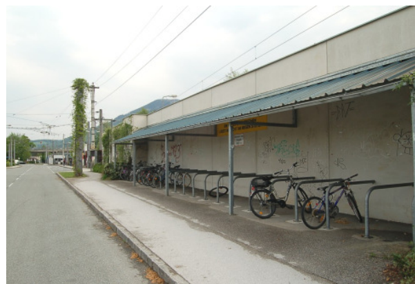
Abbildung 216: Beispiel für eine überdachte Radabstellanlage mit zusätzl. Witterungsschutz an der Rückseite
