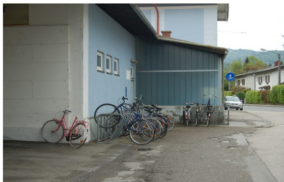
Abbildung 232: Beispiel für eine mangelhafte Überdachung einer Fahrradabstellanlage, das Vorderdach bietet keinen Witterungsschutz
