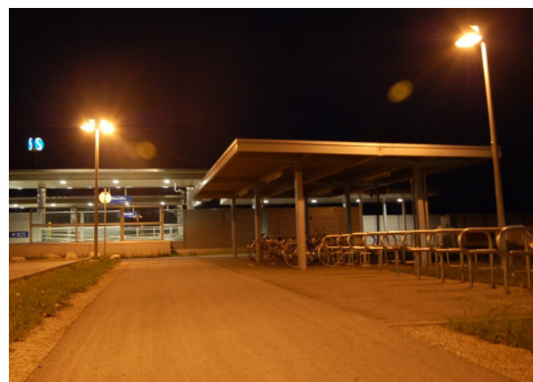
Abbildung 221: Beispiel für eine Radabstellanlage mit Beleuchtung durch allgemeine Vorplatzbeleuchtung
