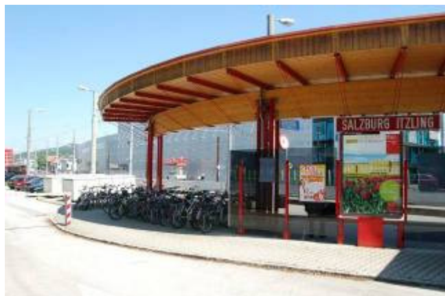
Abbildung 50: Lokalbahnhof Salzburg Itzling, überdachte Fahrradabstellanlage und Fahrradboxen (links hinten)
