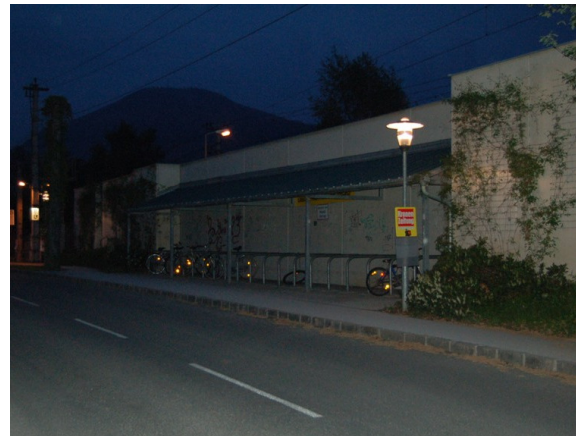
Abbildung 235: Beispiel für eine Radabstellanlage mit mangelhafter Beleuchtung
