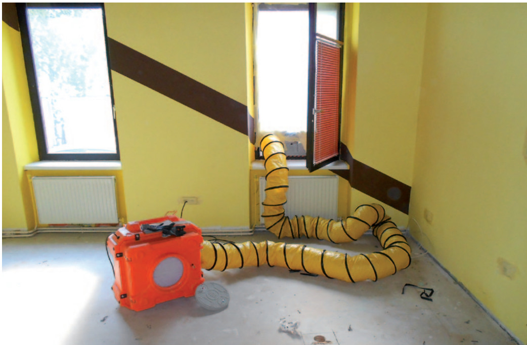
Professionelle Trocknungsmaßnahmen nach Schimmelsanierung
