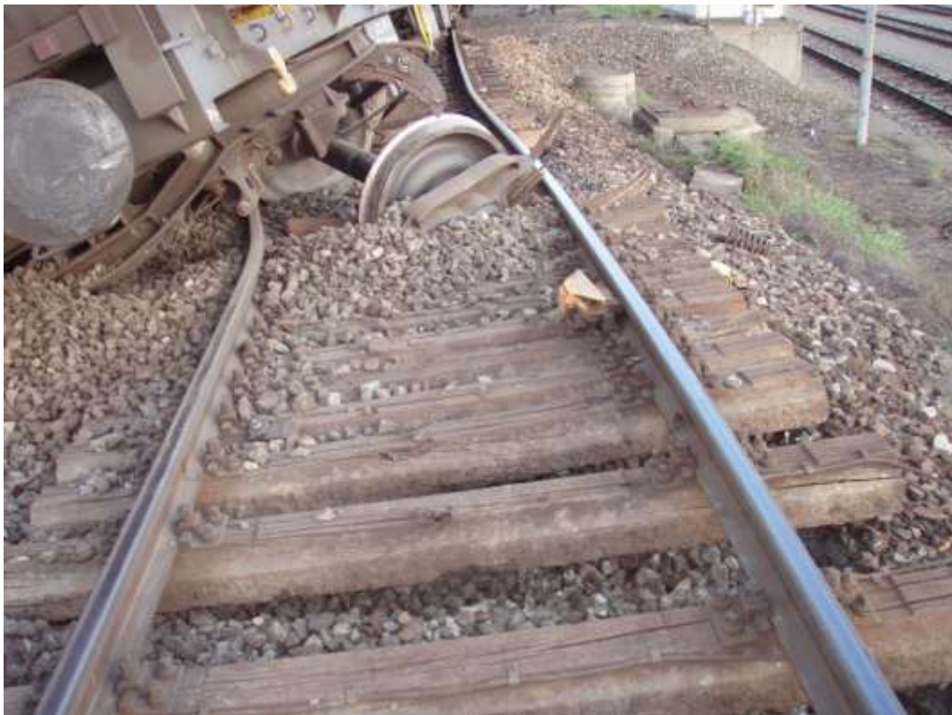
Abbildung 26 Verhakter RS 3 (II. RS in Fahrtrichtung) und dadurch in Längsrichtung verschobene Schwellen
