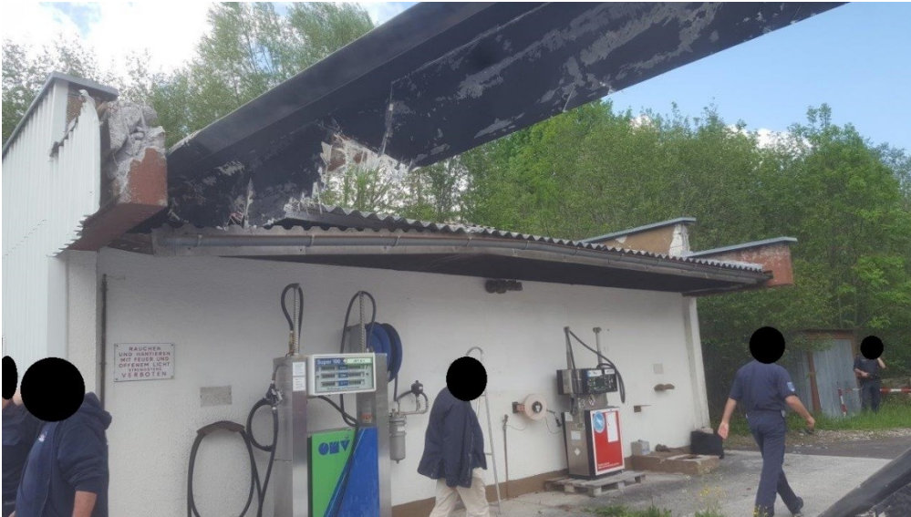
Abb. 4: Tankstellendach, Rotor – Quelle: Luftfahrzeughalter
